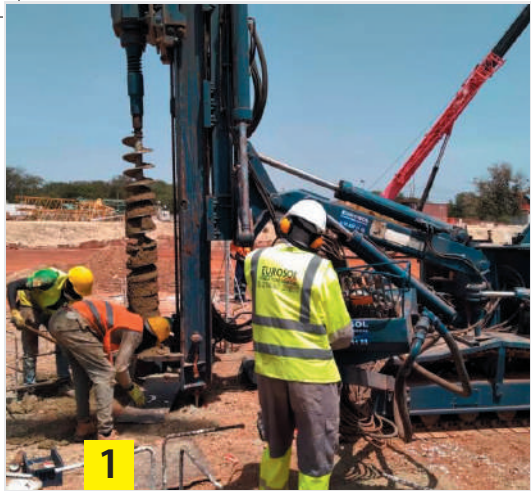
1 Réalisation de 1500 micropieux dans le projet de construction de la nouvelle centrale 300MW du Cap-des-biches pour ÇALIK ENERGY
