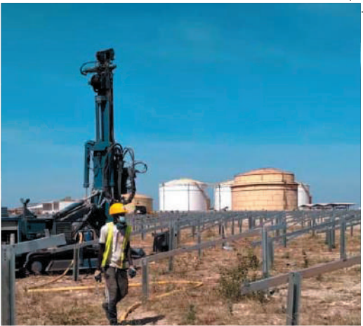
7 Réalisation de 257 micropieux à Bargny pour la société ACT Afrique SA, dans le projet de construction d'une centrale à panneau solaire
