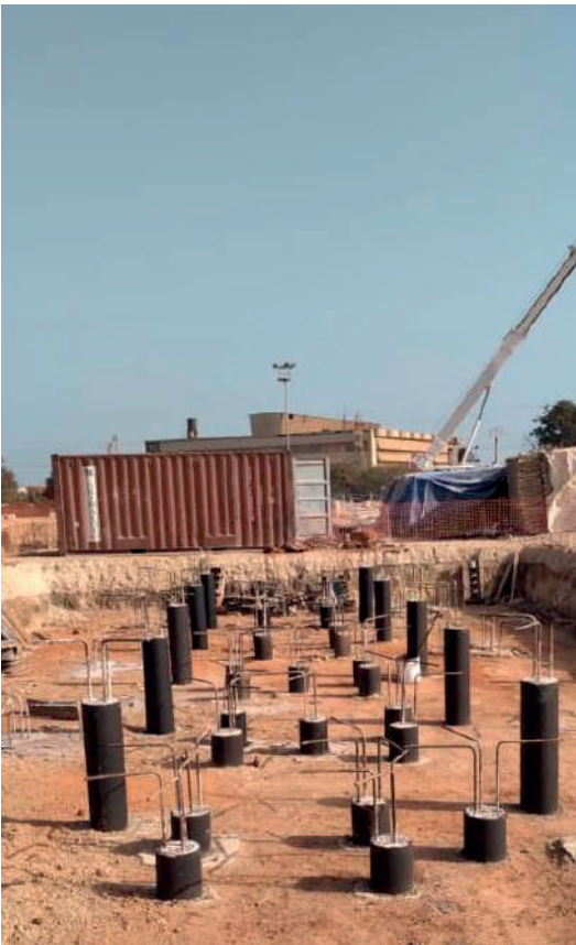
10 Réalisation de micropieux Ø300mm de 9m dans le cadre des travaux de construction du Centre de Référence dans les Métiers du Numérique (NRMN)
