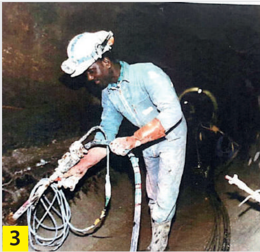
3 Injection de coulis de ciment
